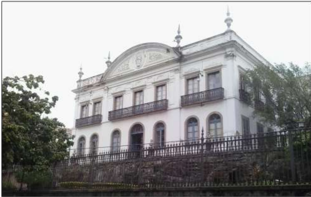
Hospital da Beneficência Portuguesa. Rua Santo Amaro, Bairro da Glória.
